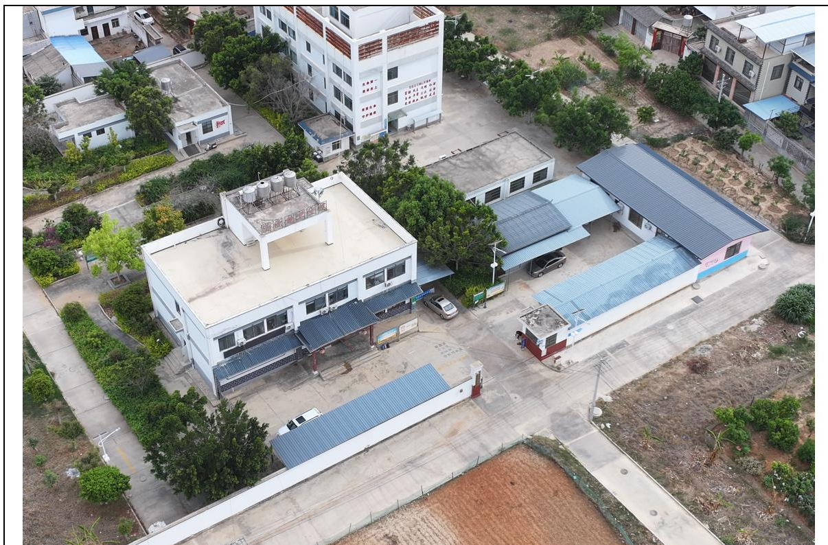
图 2.1-5 涛源卫生院主入口现状（2025 年 5 月）
