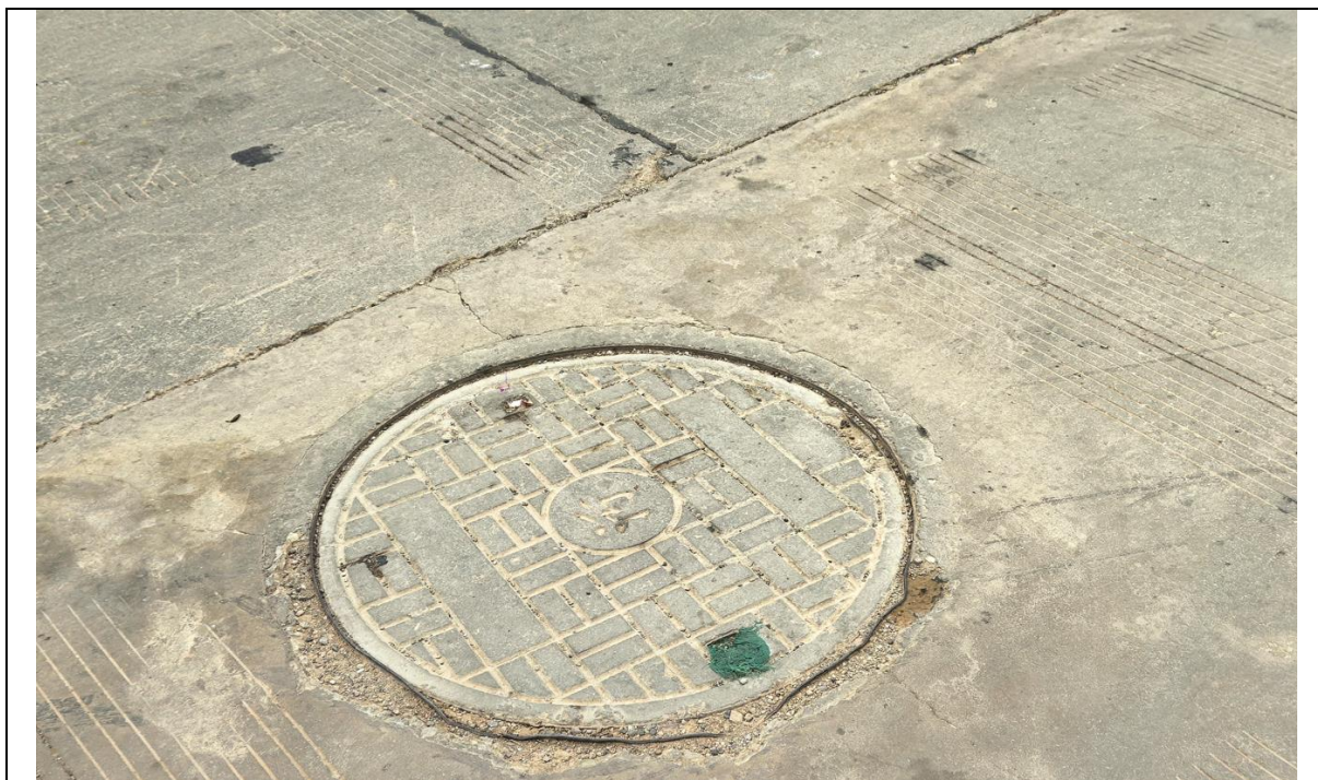
图 2.1-9 污水管现状（2025 年 5 月）
