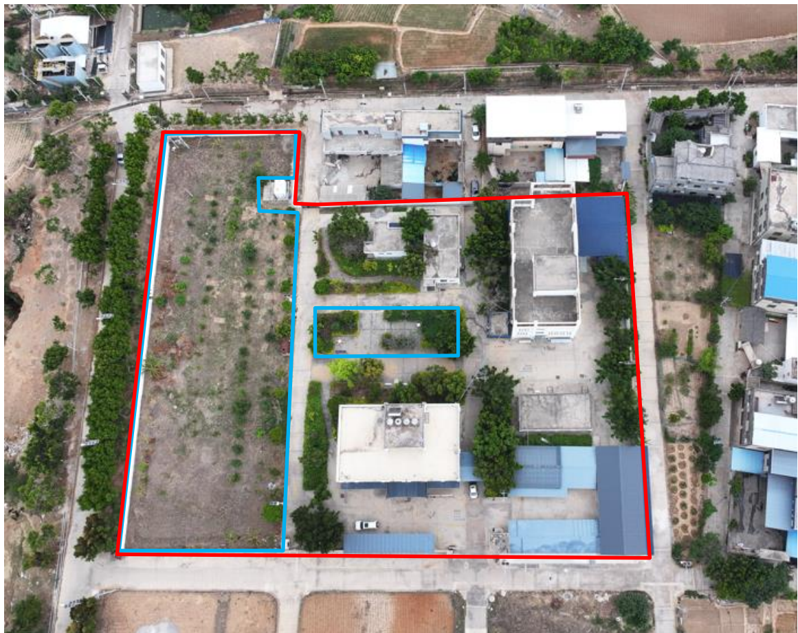
图 8 在现状基础上新建 1 栋业务楼与停车场（2025 年 5 月）
