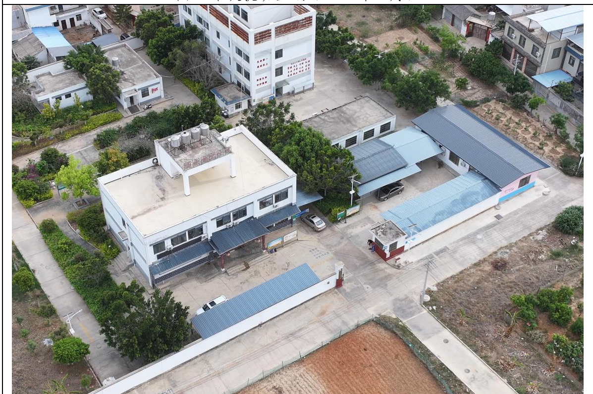
图 4 涛源卫生院主入口现状（2025 年 5 月）
