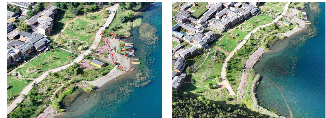
图 2-9 小落水湖岸线生态修复点现状照片（2025 年 12 月）
