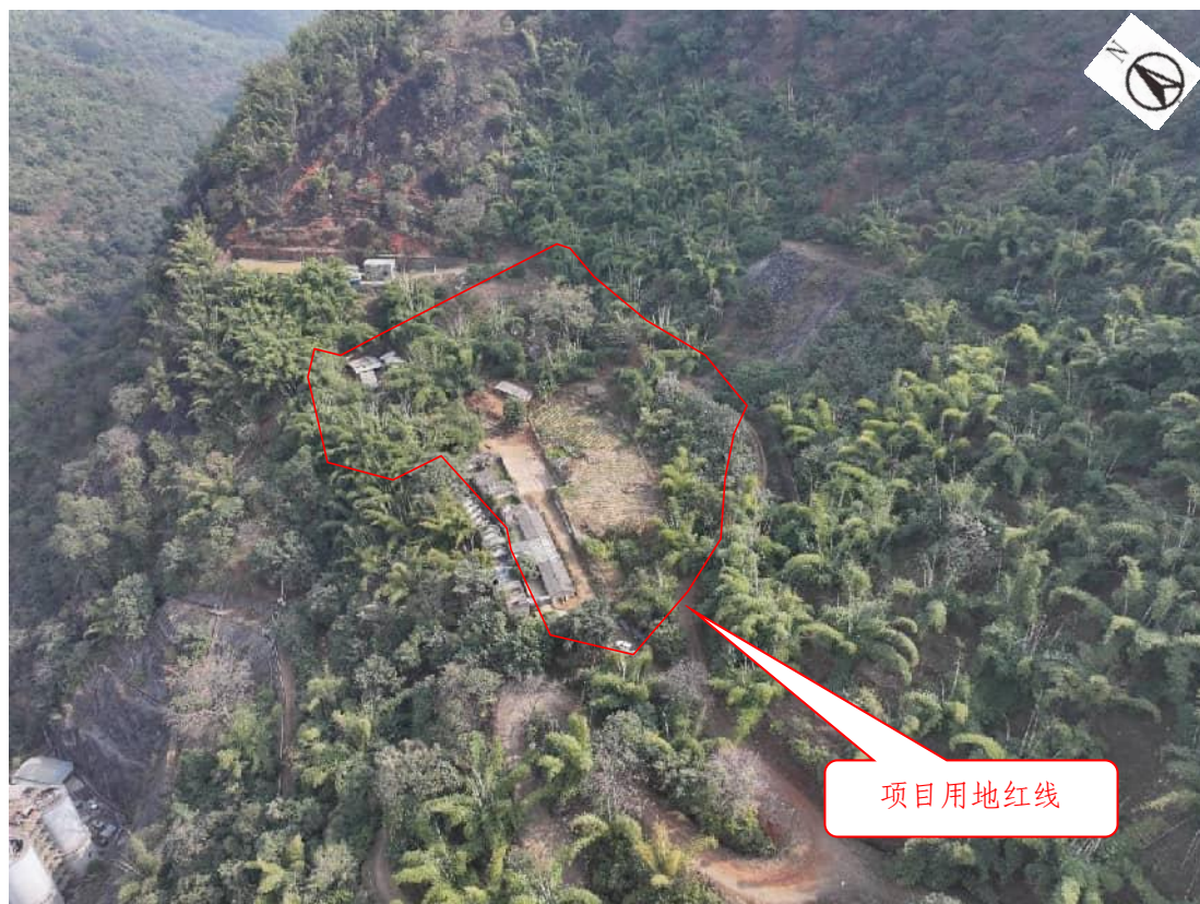
图 2-2 项目区航拍现状（2026 年 2 月）
