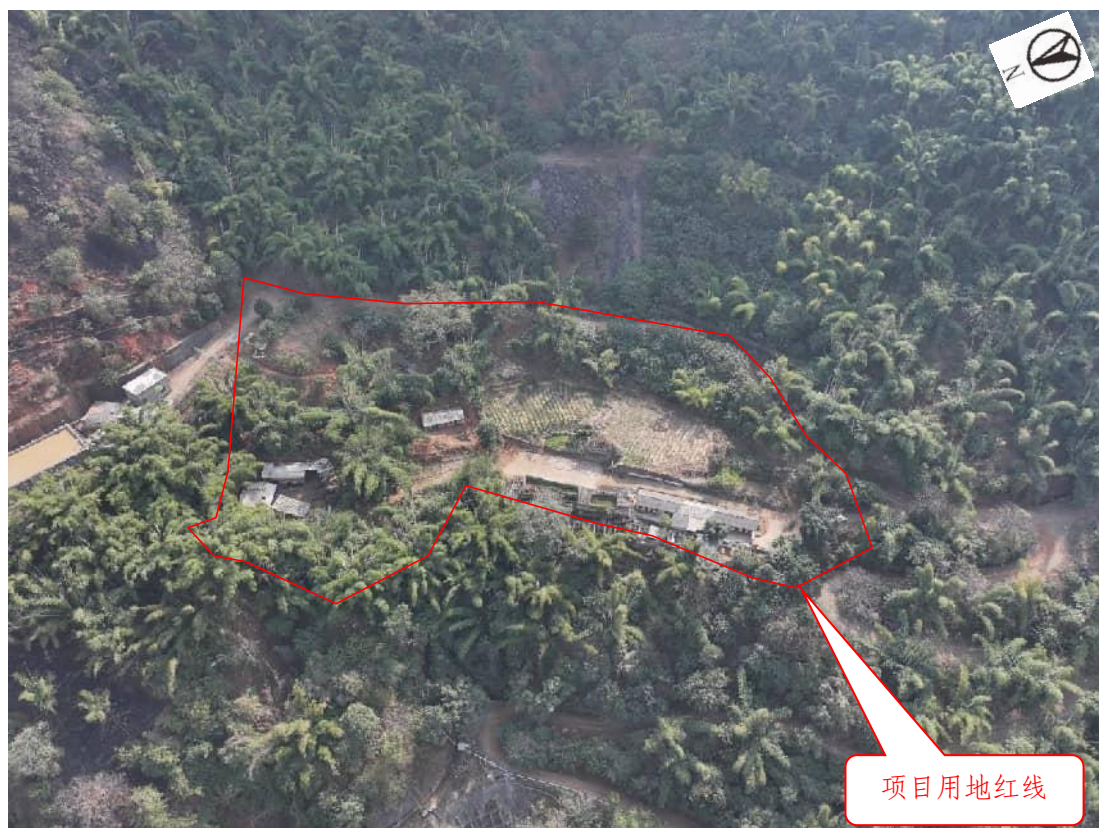
图 2-3 项目区航拍现状（2026 年 2 月）
